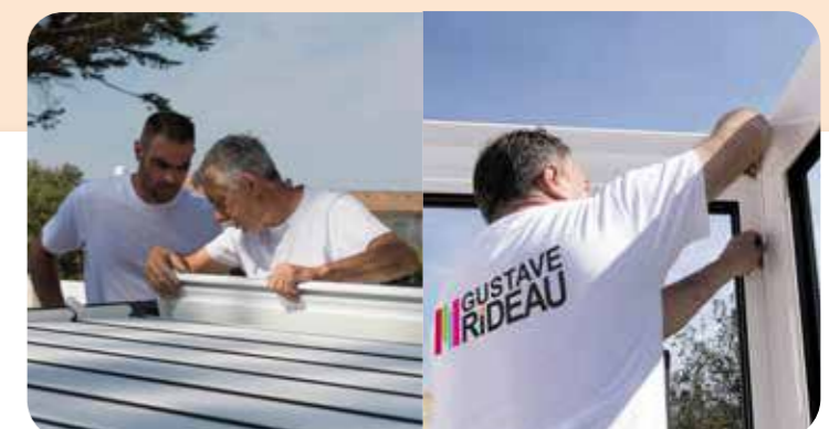
Une pose réalisée dans les règles de l'art
